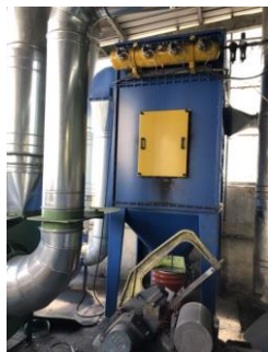
extractor fan & filters
